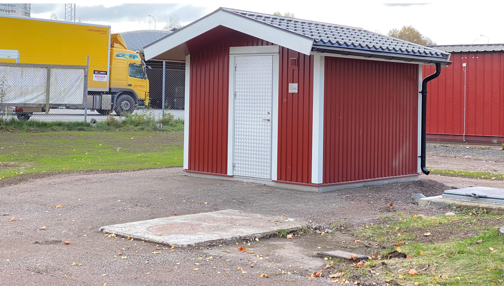
Den nya avloppspumpstationen vid Ekeby.
